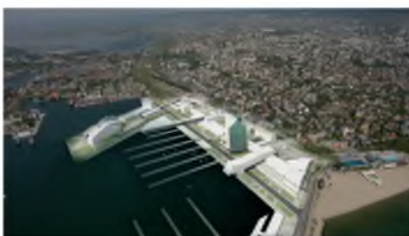
Фиг. 10. Визуализация на градоустройствената реконструкция на територията на пристанище „Варна-Изток“, колектив от ВСУ „Черноризец Храбър“ с участие на автора на настоящата разработка и ръководител проф. д.а.н. арх. Иван Никифоров Източник: Личен архив на автора
